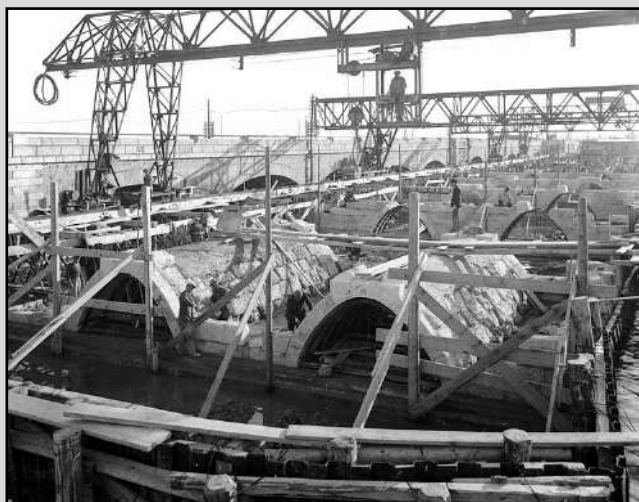
Il ponte "Littorio" (oggi "della Libertà") in fase di costruzione (1932)
