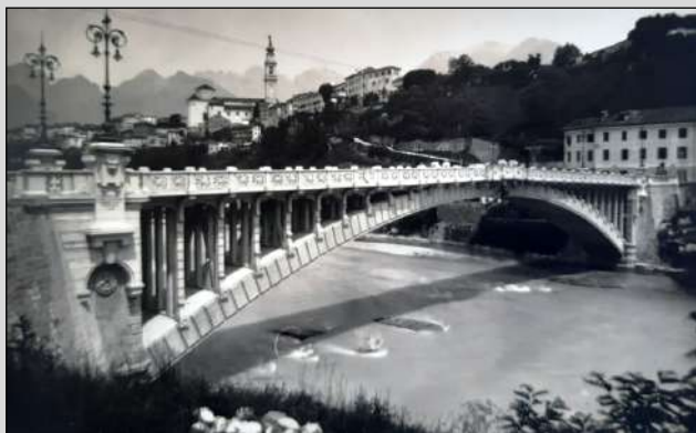
Fig. 14 - Ponte "della Vittoria" a Belluno (1926)
